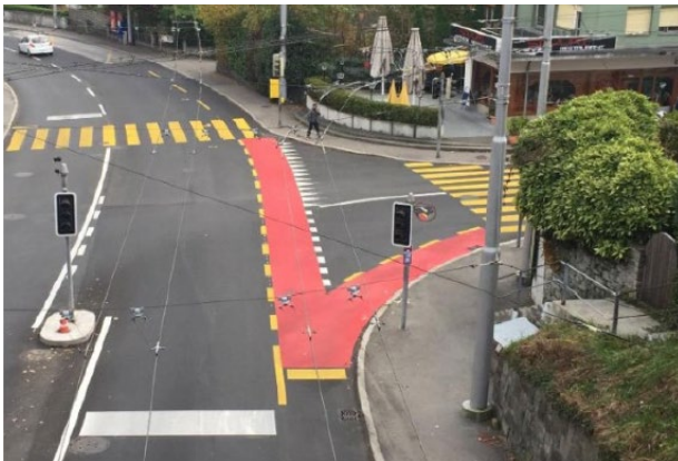
Abbildung 6: Markierung von Gefahrenstellen (Schweiz)
